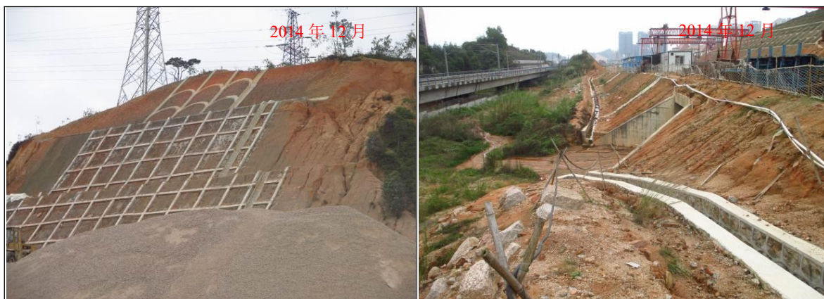
高边坡分级防护，实施拱形浆砌石及钢筋锚索格构梁护坡；路基修筑浆砌石排水沟
