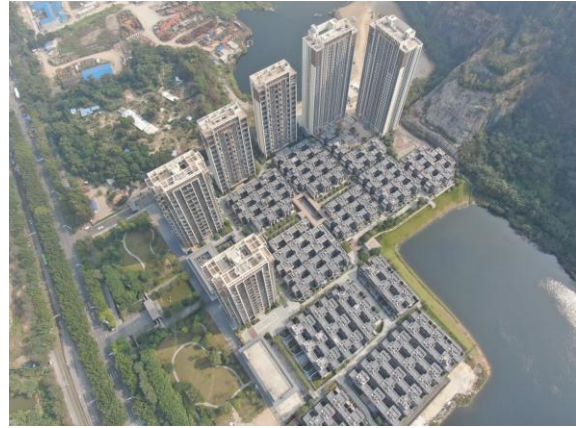
现场：建筑物已完成建筑物施工，道路广场区完成绿化，绿化工程区完成园林绿化。
