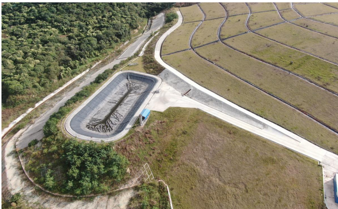
堆体下游（坝体、渗滤液调节池、框格护坡及排水设施等）
