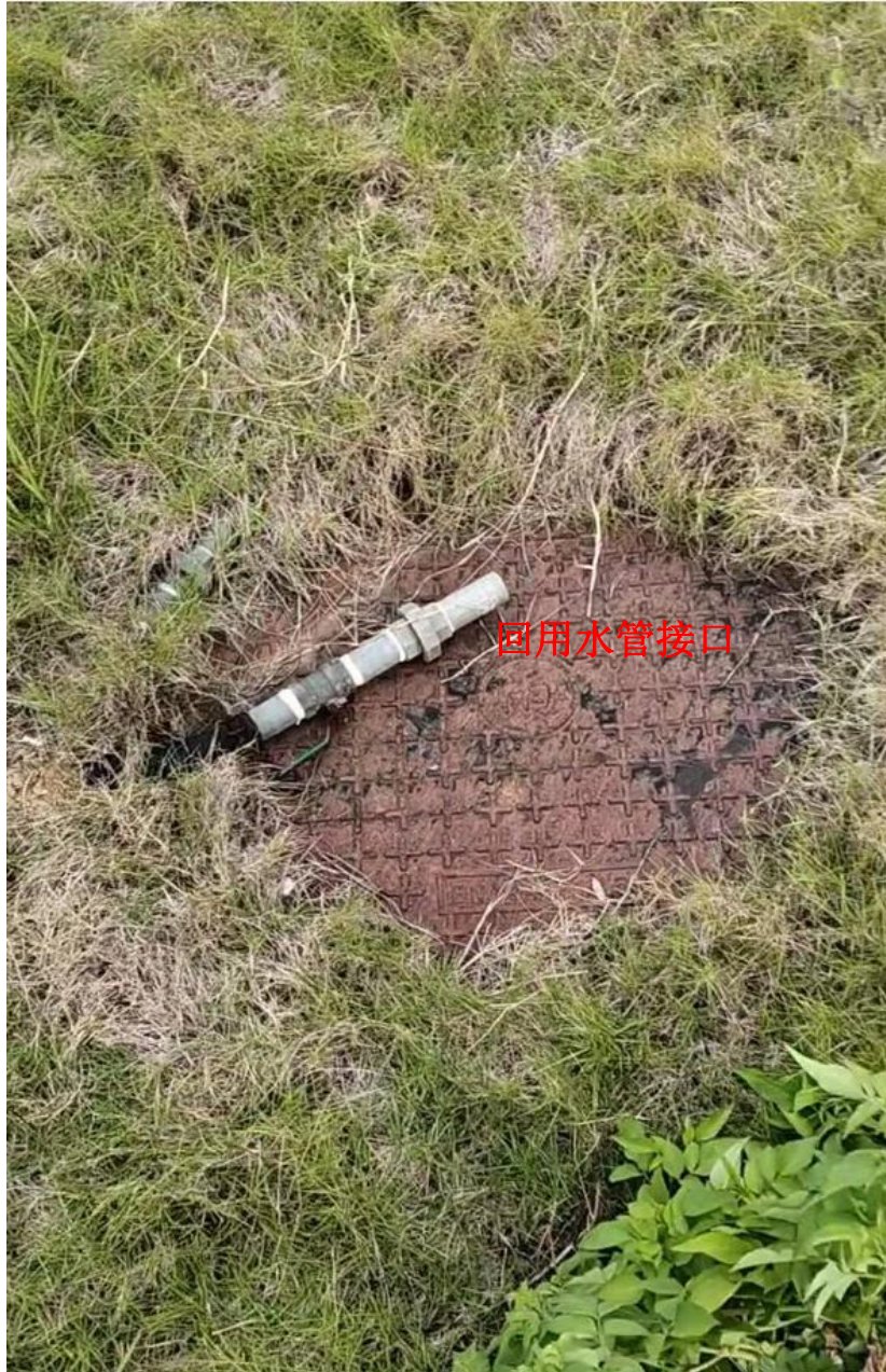
图 7.4-4 经处理达标后的回用水管
