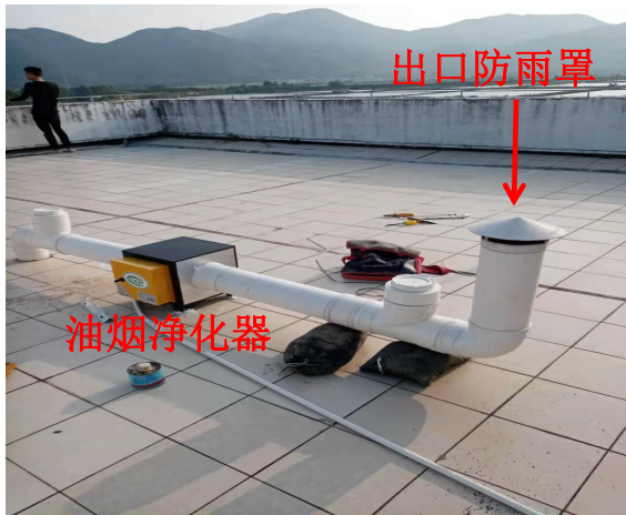
图 7.4-2 (三楼) 楼顶油烟净化器及检测孔布置
